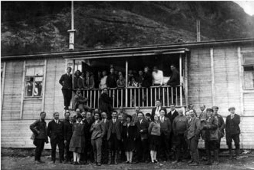
Первое здание Хибинской горной научной станции «Тьетта», 1930 г. Научный архив ФИЦ КНЦ РАН
