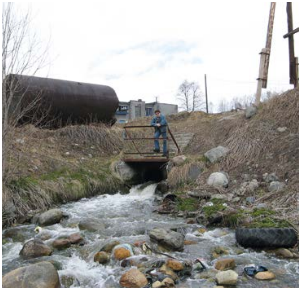
Загрязнение реки Белая бытовым мусором (слева) и сток очистных сооружений г. Кировска (справа). Фото Д. Денисова
