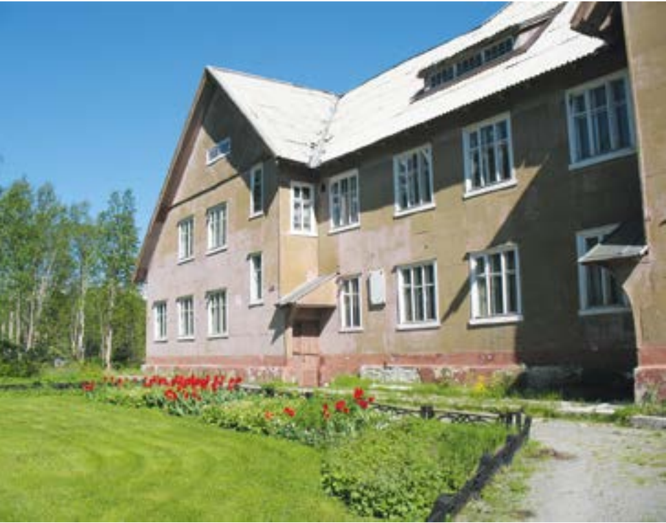
Здание главного лабораторного корпуса ПАБСИ, объект культурного наследия регионального значения. Фото О. Белкиной
